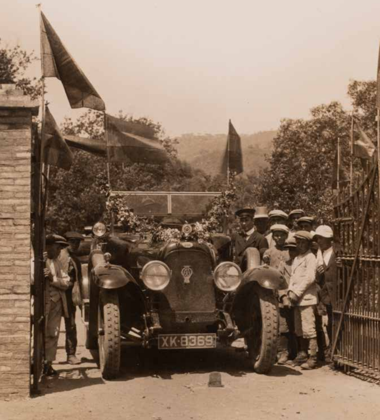
Llegada a la Alcaría el día de la inauguración del puente el 28 de abril de 1927. Sus propietarios, los condes de Torre Díaz, llegaban desde Londres a Cádiz en barco y tras varios días de travesía llegaban a la Alcaría. Hasta que estuvo construido el puente debían acampar hasta que bajara el caudal de la garganta del Astillero. El coche es un Fiat 501 con el logo de Automóvil Club Inglés en el radiador. La carrocería del coche es inglesa
